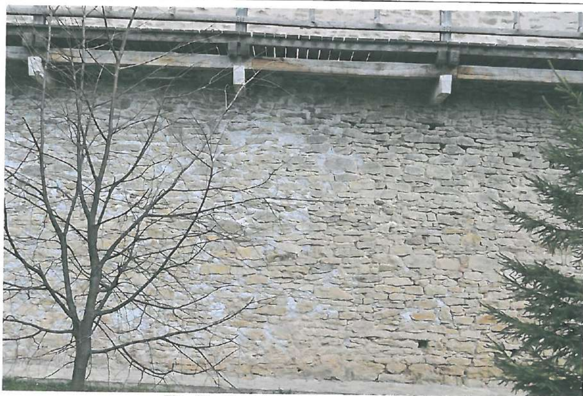
Fig. 46 – Zidul de incintă pe latura de est
